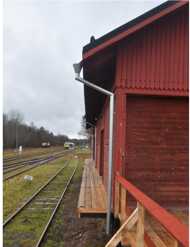
Magasinet efter renovering, sett från nordväst. Här syns den rekonstruerade lastbryggan.
