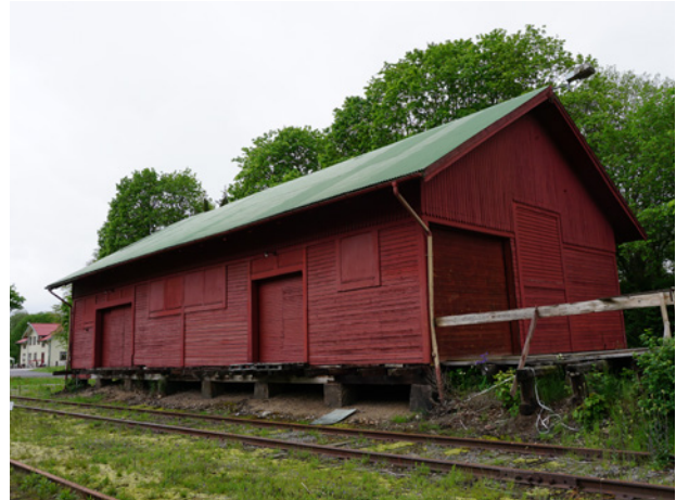
Magasinet före renovering. Här syns det senare ditlagda korrugerade plåttaket. Lastbryggan var borttagen och de bärande bjälkarna uppvisade rötskador.
