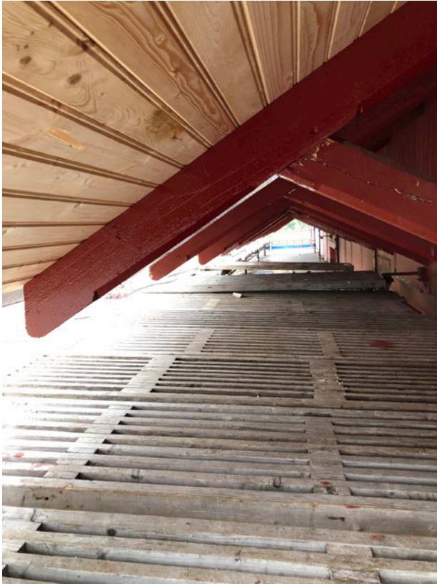
Takstolarna har reparerats och målats med röd linoljefärg. Här syns även gjorda lagningar i undertaket.
