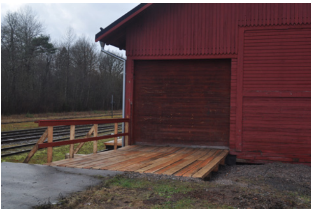
Lastbryggan mot öster ersattes i samband med syllbytet.
