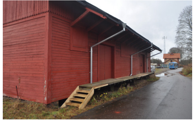
Stuprören i zinkmagnesium med vattkupor och skarpa böjar. Här syns även de lagningar som gjorts på den norra lastbryggan.
