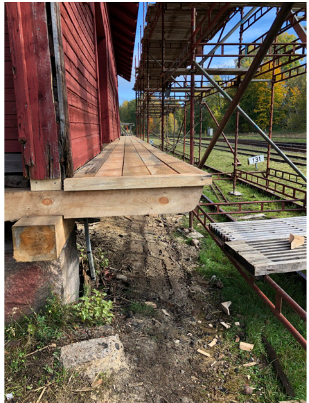
Ny lastbrygga mot spårsidan längs byggnadens södra fasad.
