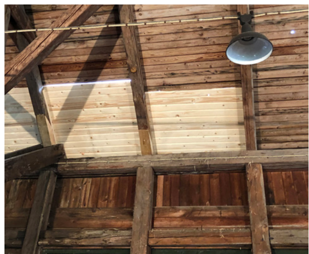
Undertaket under renovering. Skadad pärlspont har ersatts med ny.
