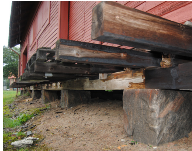
Syllen uppvisade före renoveringen kraftiga rötskador på flera ställen.
