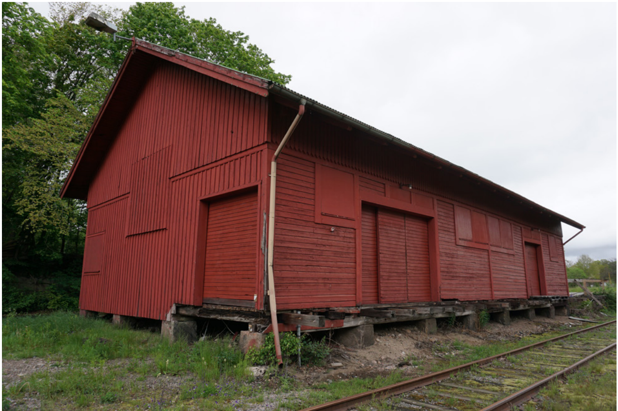
Godsmagasinet före renovering, sett från sydväst.
