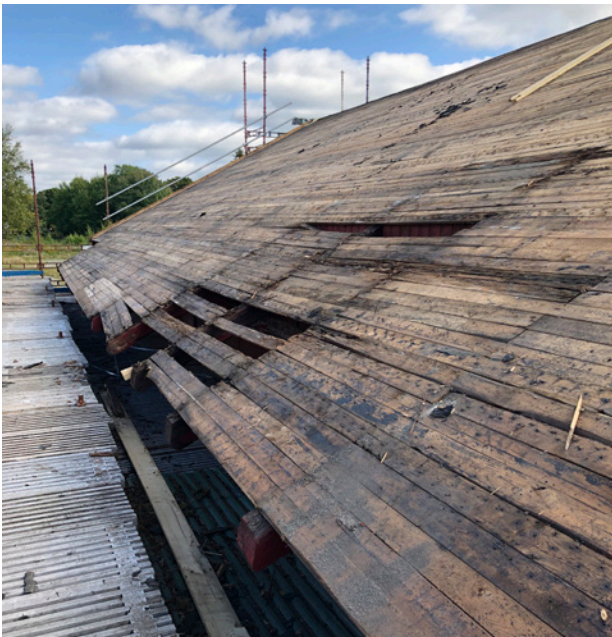
Undertaket har frilagts. Här syns de skador som orsakats av att en takplåt saknats efter påkörning.
