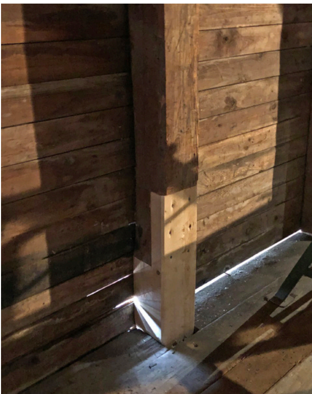
Rötskadade partier av bärande stolpar har ersatts av friskt virke.
