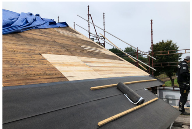
Underlagspappen monteras.
