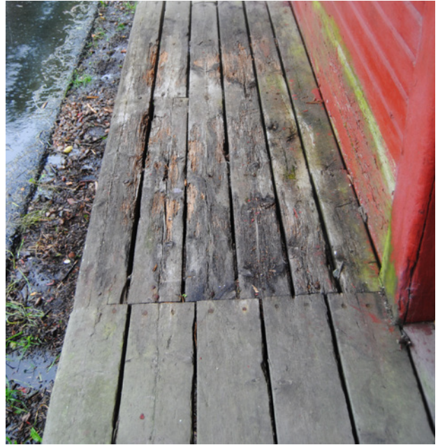
Lastbryggan mot norr före renovering. Takläckaget har orsakat rötskador i planken.
