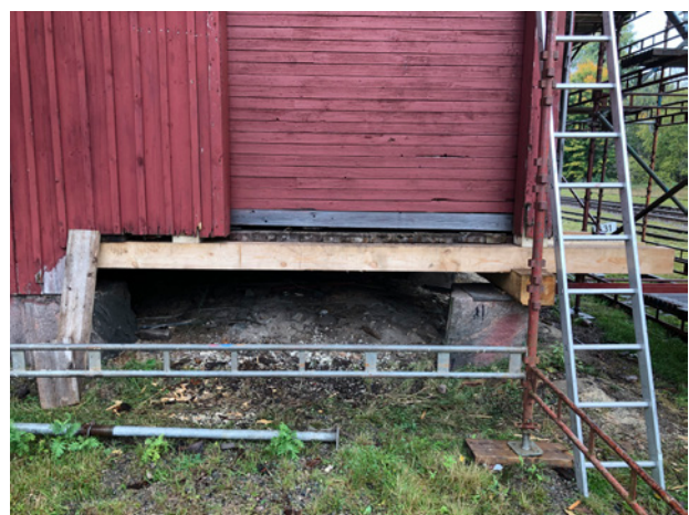
Bjälklag/syll utbytt längs den sydvästra gaveln.
