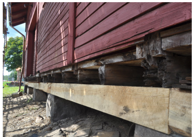
Syllen efter byte. Ovanför syns skadorna i bjälklag och en stolpe.
