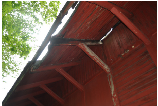
Skador i takfoten på byggnadens norra sida.
